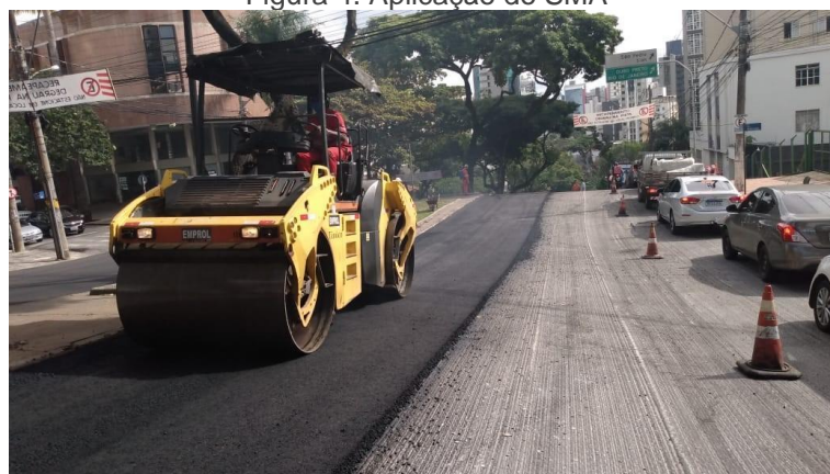
Figura 4. Aplicação do SMA
